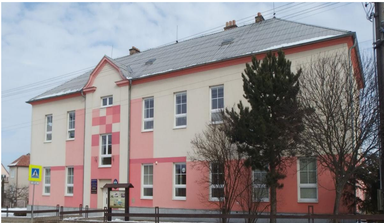
Obrázek 17: Budova Základní a mateřské školy 22
